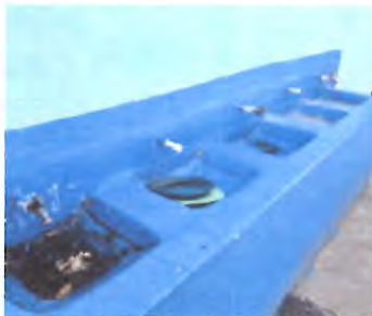
Foto 5: SERVICIOS SANITARIOS Y SUS ACCESORIOS Sustitución de chorros
