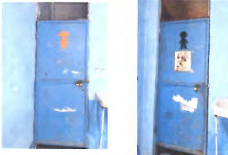
Foto 3: PUERTAS Mantenimiento a puerta metálica existente retiro de óxido, suciedad y pintura deteriorada; incluye cepillado, lijado y aplicación de pintura En baños
