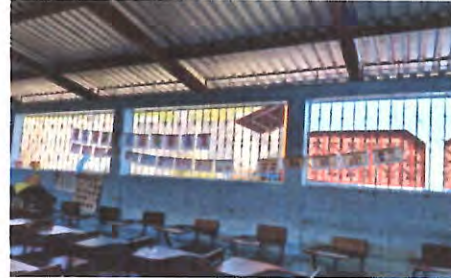
Foto 2: VENTANAS Sustitución de ventanas; sistema de apertura: Corredizas, Perfiles color blanco estandar, Material del marco: PVC Material de la ventana: Vidrio, sellado perimetral. Aula
