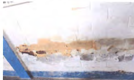
Foto 4: REPARACIÓN DE REPELLO Y CERNIDO DE PAREDES Reparación de reello y cernido en muro de mampostería con aplicación de acabado uniforme. Aula 1 y Aulas cerca del escenario y dirección
